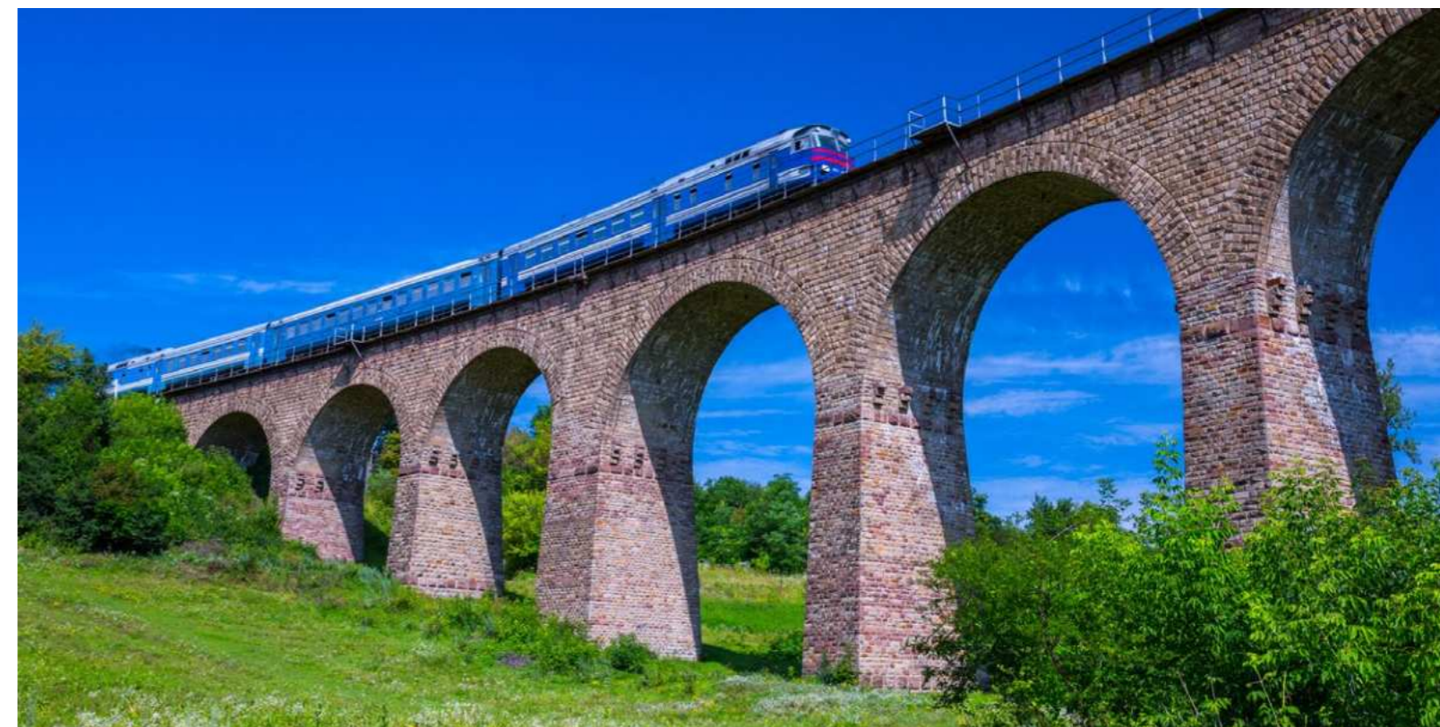
Залізничний віадук. Село Плебанівка. Липень, 2018 рік / Railway viaduct. The village of Plebanivka. July 2018
