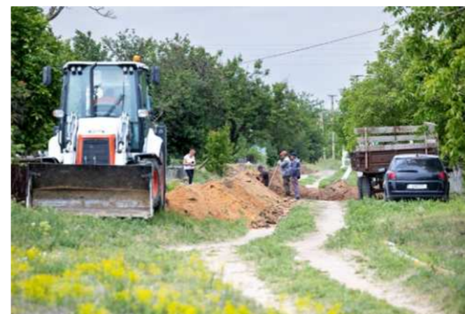
Модернізація водомережі в селі Зарічне. Травень, 2024 рік Modernization of Zarichne water supply system May 2024
