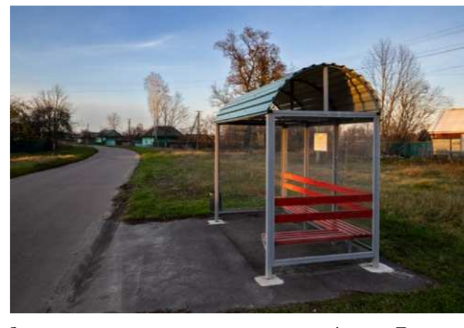
Зупинка громадського транспорту, виготовлена за підтримки Програми USAID DOBRE. Село Наумівка. Листопад, 2022 рік A public transport stop made with the support of the USAID DOBRE Program. The village of Naumivka. November 2022
