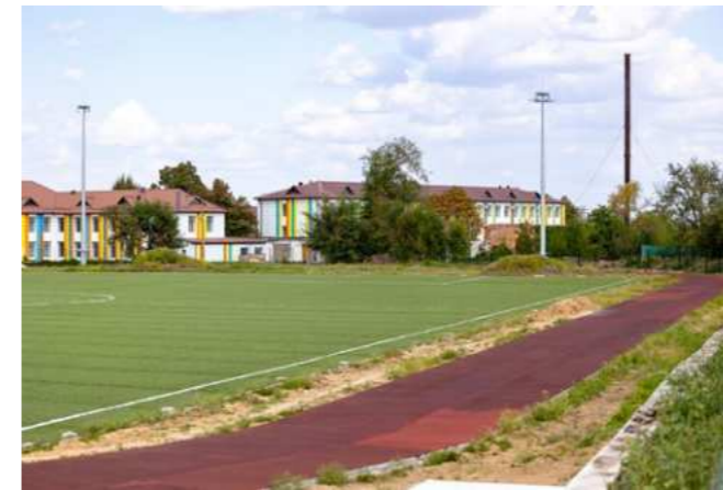
Реконструкція місцевого стадіону. Вересень, 2023 рік Reconstruction of the local stadium. September 2023
