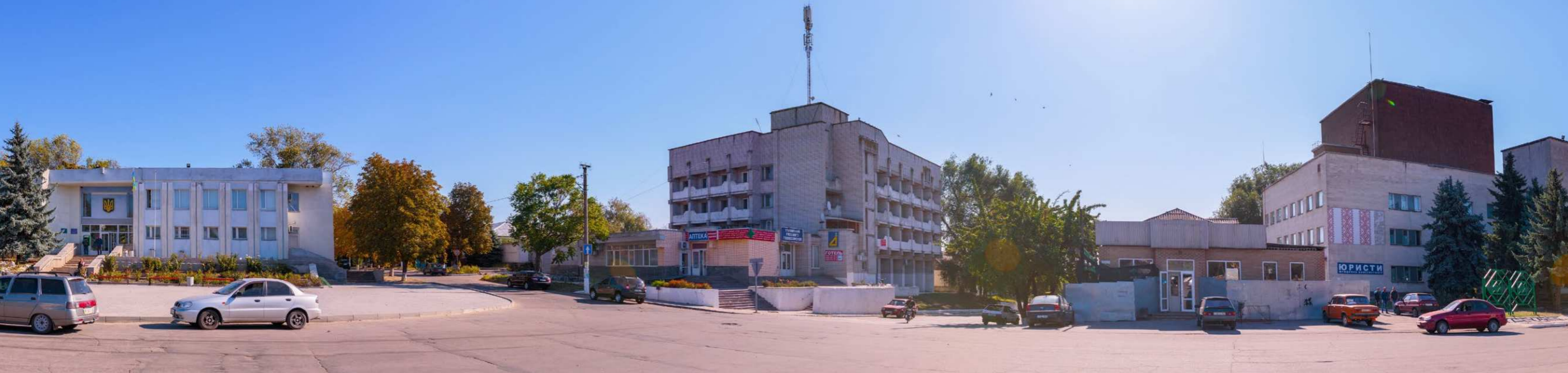
Центральна площа селища Покровське, де за підтримки Програми USAID DOBRE відновлено вуличне освітлення. Вересень, 2017 рік The central square of Pokrovsk village, where street lighting was restored with the support of USAID DOBRE Program. September 2017
