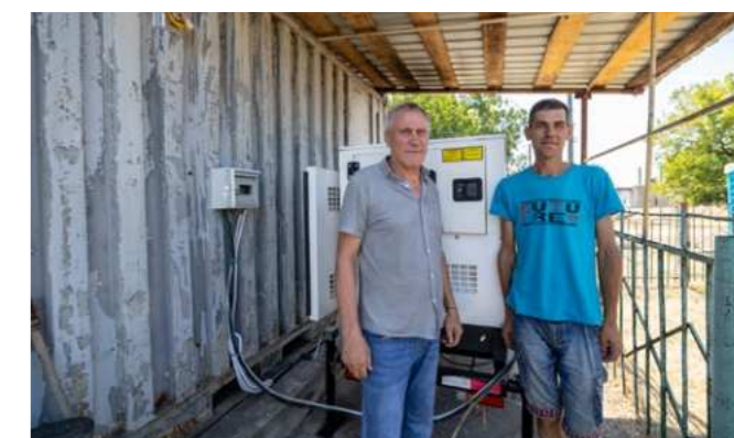
Валерій Тополь, директор КП «Водолій» із колегою. Техніка та обладнання КП «Водолій», надані Програмою USAID DOBRE. Липень, 2024 рік / Valeriy Topol, director of the Vodolii utility company, with a colleague. Machinery and equipment provided to Vodolii by USAID DOBRE Program. July 2024
