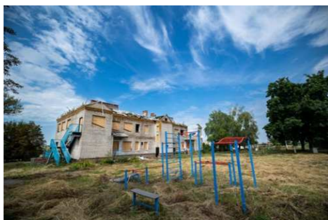
Дитячий реабілітаційний центр у селі Шевелівка, зруйнований Росією в березні 2022 р. Липень, 2023 рік / Children's rehabilitation center in the village of Shevelivka; destroyed by Russia in March 2022. July 2023
