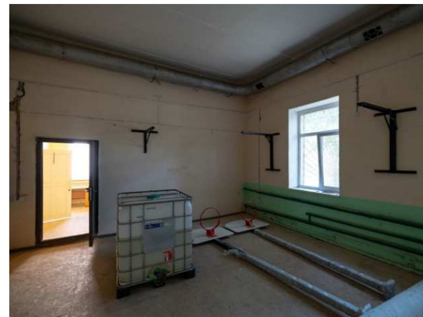
Ремонт майбутнього приміщення Молодіжного центру Софіївської громади. Спеціальне обладнання та меблі для медіакімнати Молодіжного центру, придбані Програмою USAID DOBRE. Вересень, 2023 рік / Renovation of the future premises of Sofiivska community Youth Center. Special equipment and furniture for the Youth Center's media room, purchased by USAID DOBRE Program. September 2023
