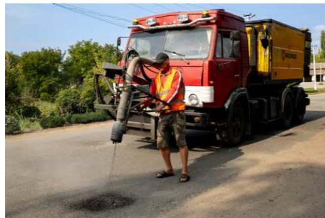
Машина для ремонту доріг, придбана за підтримки Програми USAID DOBRE. Вересень, 2023 рік / A road repair machine purchased with the support of the USAID DOBRE Program. September 2023
