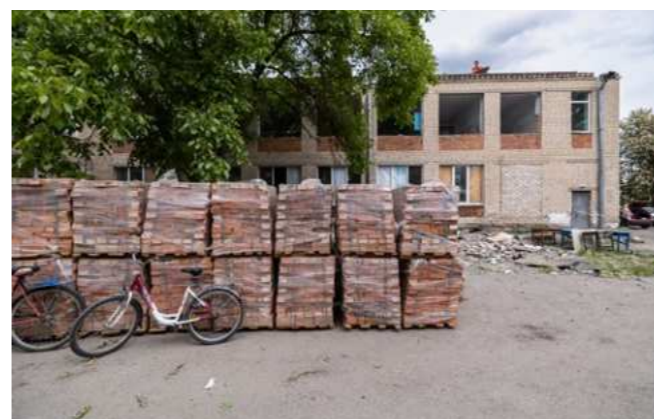
Відбудова Високопільської опорної школи. Травень, 2024 рік Reconstruction of the Vysokopillya Hub School. May 2024
