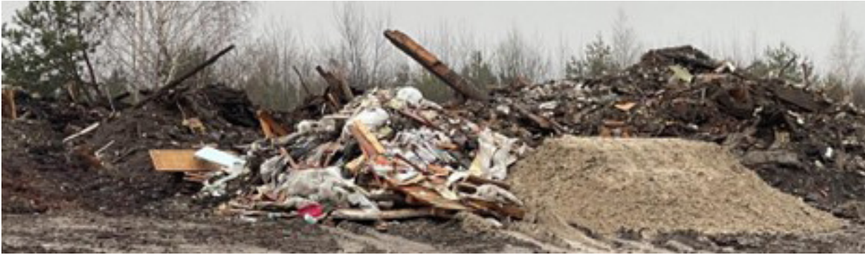
Рисунок 3.10. Майданчик для тимчасового зберігання відходів від руйнувань (м. Буча, вул. Києво-Мироцька, фото авторів звіту, 14.02.2024 р.)
