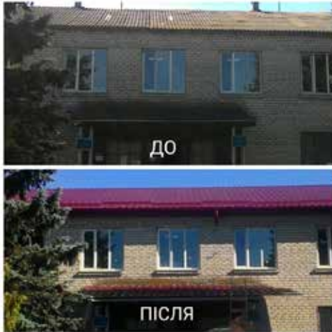
Андмінбудівля сільської ради в с. Велицьк (ремонт будівлі, заміна даху), Велицька громада
