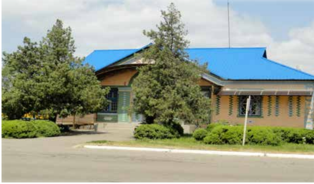
Реконструкція приміщення Омелницької сільської ради, Омелницька ОТГ
