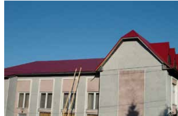
Капітальний ремонт даху будинку культури по вул. Шевченка в с. Княждвір, Печеніжинська громада
