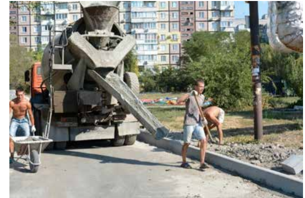
Капітальний ремонт вул. Теплична, Слобожанська (Ювілейна) ОТГ
