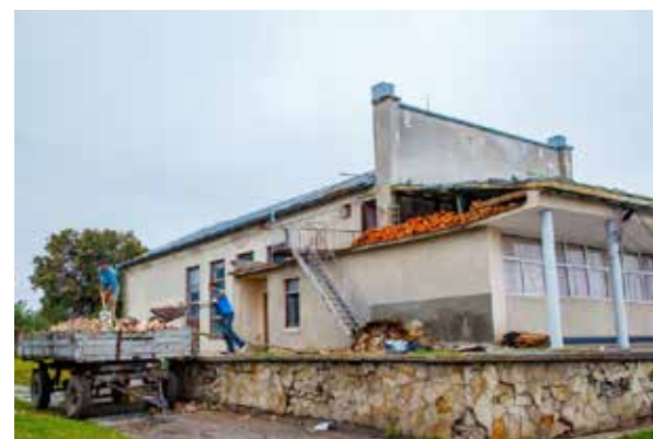
Ремонт даху в будинку культури в с. Лозова, Байковецька ОТГ
