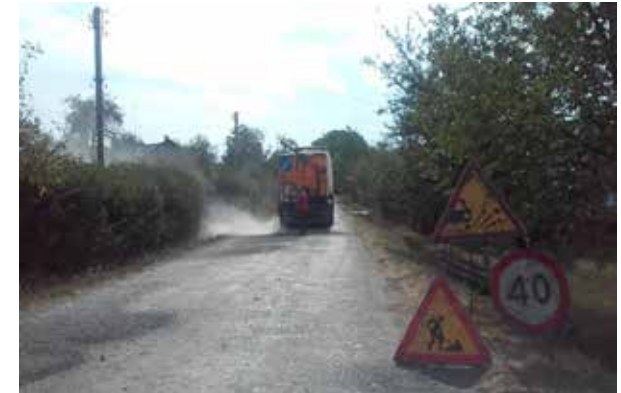
Ремонт місцевих автомобільних доріг, Золотопотіцька громада
