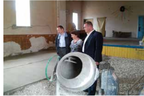
Капітальний ремонт Будинку культури в с. Росохуватець, Підволочиська громада
