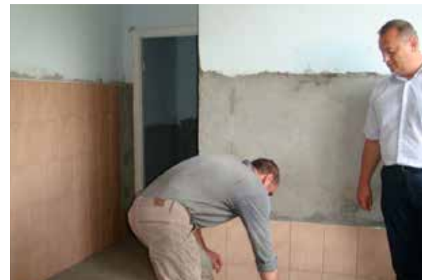
Капітальний ремонт системи опалення в Підволочиському дошкільно- навчальному комплексі
