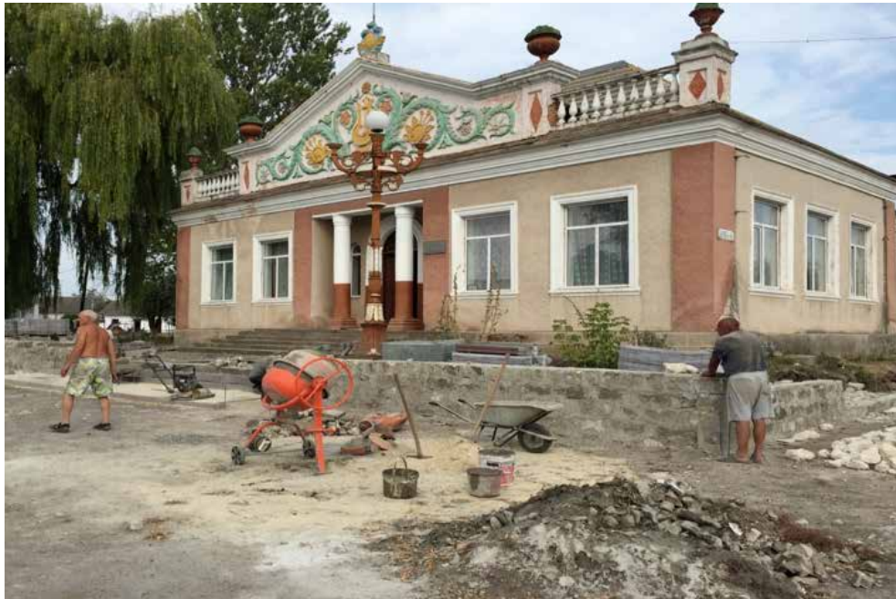
Будинок культури (капітальний ремонт будинку, заміна даху, ремонт сходів), Козлівська ОТГ
