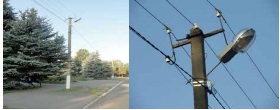
Реконструкція вуличного освітлення в с.Омельник
