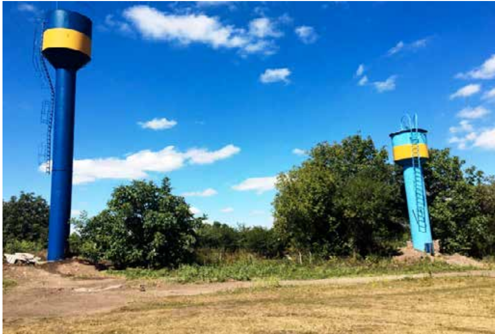
Ремонт водонапірних башт в смт. Війтівці
