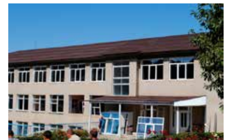
Капітальний ремонт та заміна вікон у ЗОШ с.Рашків Рукшинської ОТГ
