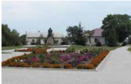
Будівництво тротуарів, благоустрій громадської території в Іванівській громаді
