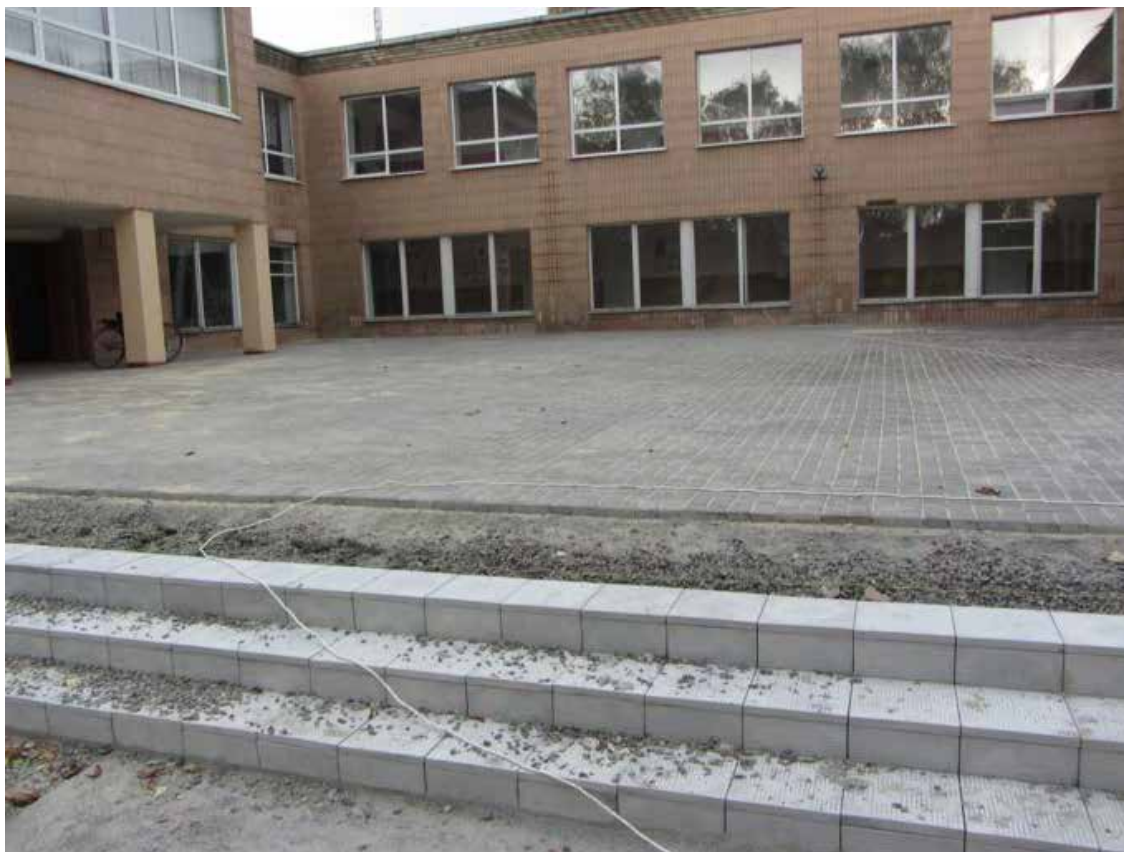
Ремонт подвір'я Мокрокалігирської ЗОШ, Мокрокалігирська громада
