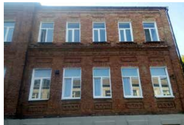
Капітальний ремонт школи, Сурсько- Литовська ОТГ
