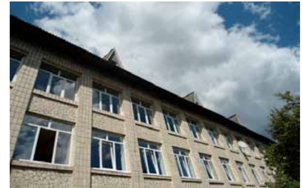
Капітальний ремонт приміщення Печеніжинської ЗОШ І-ІІІ ст. по вул. Шевченка, 1, Печеніжинська громада
