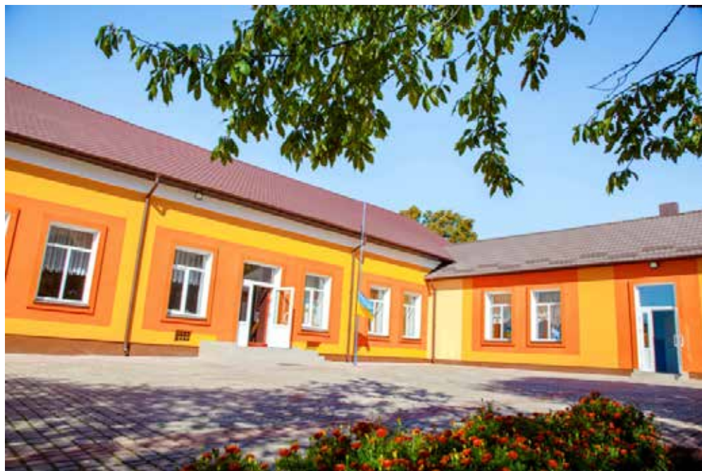
Капітальний ремонт покрівлі, утеплення та ремонт фасаду школи в с.Байківці, Байковецька ОТГ
