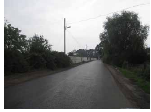
Капітальний ремонт покриття вулиці Ткача в смт. Голоби, Голобинська громада
