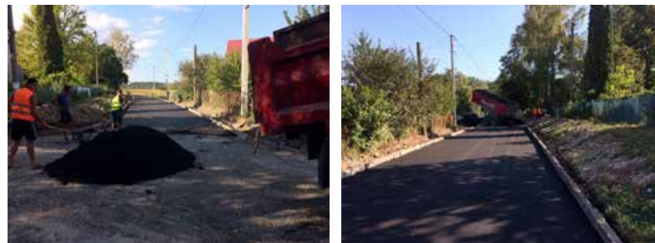
Капітальний ремонт вул. Навроцького в м. Тербовля
