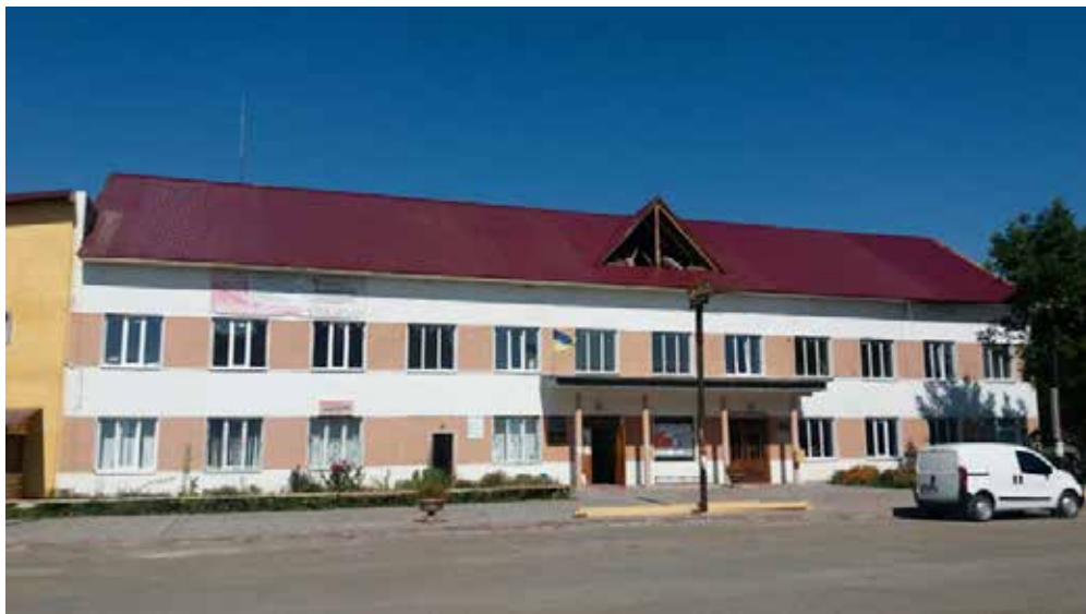
Перекриття даху в адміністративному приміщенні в с. Старі Богородчани
