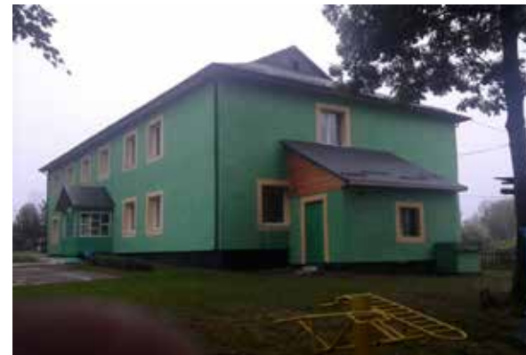
Утеплення фасаду в Станківській ЗОШ I-IIст., Верхнянська ОТГ
