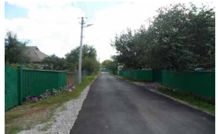
Капітальний ремонт доріг та реконструкція мереж вуличного освітлення, Білозерська ОТГ
