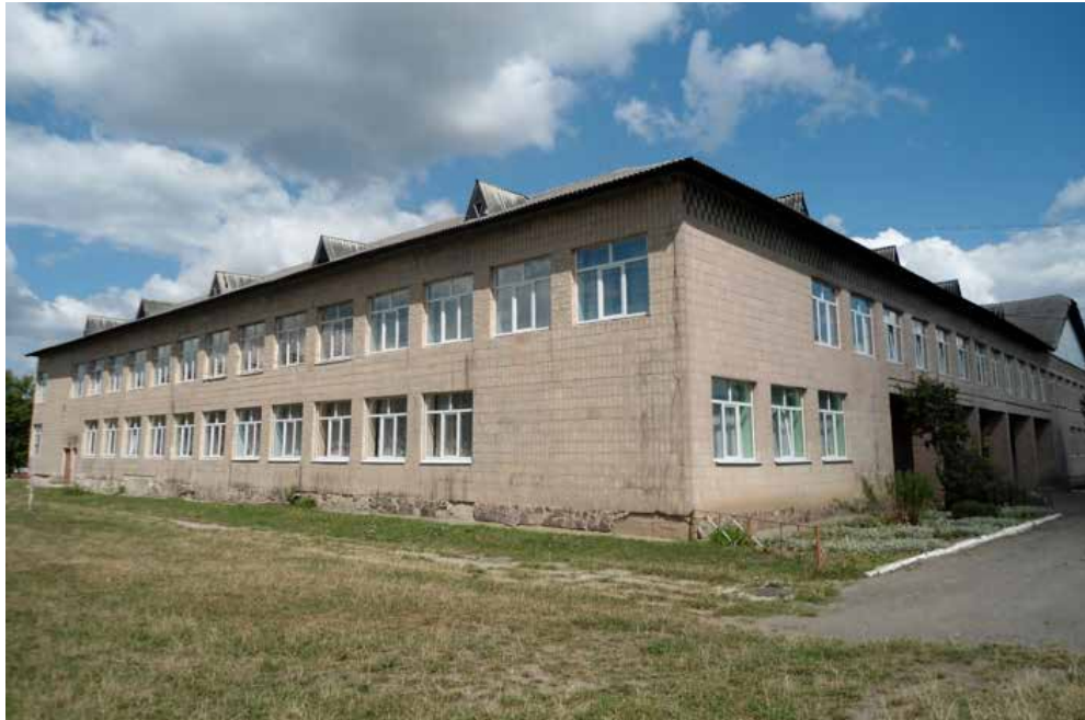
Заміна вікон у приміщенні Рунгурського НВК по вул. Шевченка, 65, Печеніжинська ОТГ
