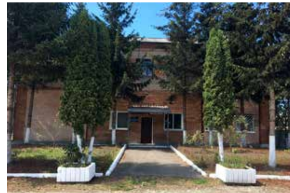
Облаштування приміщення ЦНАПу та поліцейської станції у Війтовецькій ОТГ
