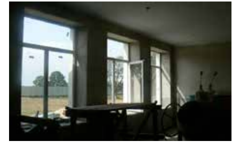
Ремонт приміщення дитячого дошкільного закладу в с.Сороцьке, Іванівська ОТГ
