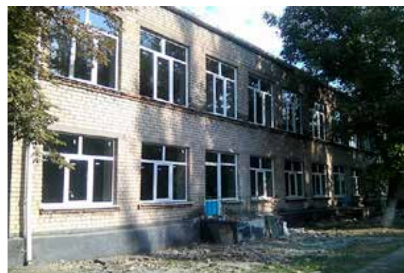
Заміна вікон у Нивотрудівській ЗОШ, Нивотрудівська ОТГ
