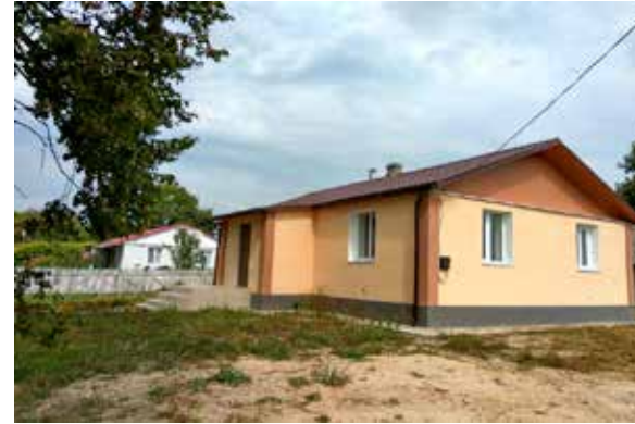
Фельдшерсько-акушерський пункт (ремонт приміщення), Тетерівська ОТГ
