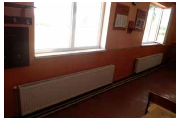
Капітальний ремонт системи опалення в Сопівській ЗОШ І-ІІІ по вул. Шкільна, 5, Печеніжинська ОТГ
