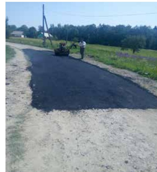
Ремонт дороги в с. Лесівка, Старобогородчанська громада
