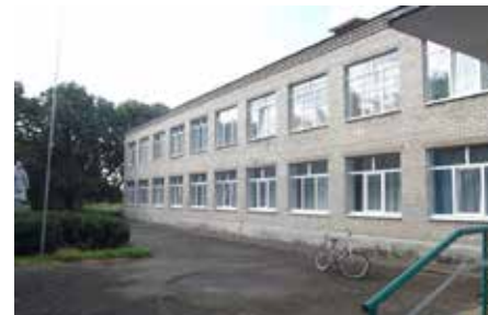
Ремонт та заміна вікон ЗОШ І-ІІІ в с.Орлово, Кочубеївська ОТГ
