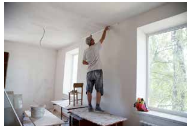
Ремонт школи в с. Стегниківці, Байковецька ОТГ
