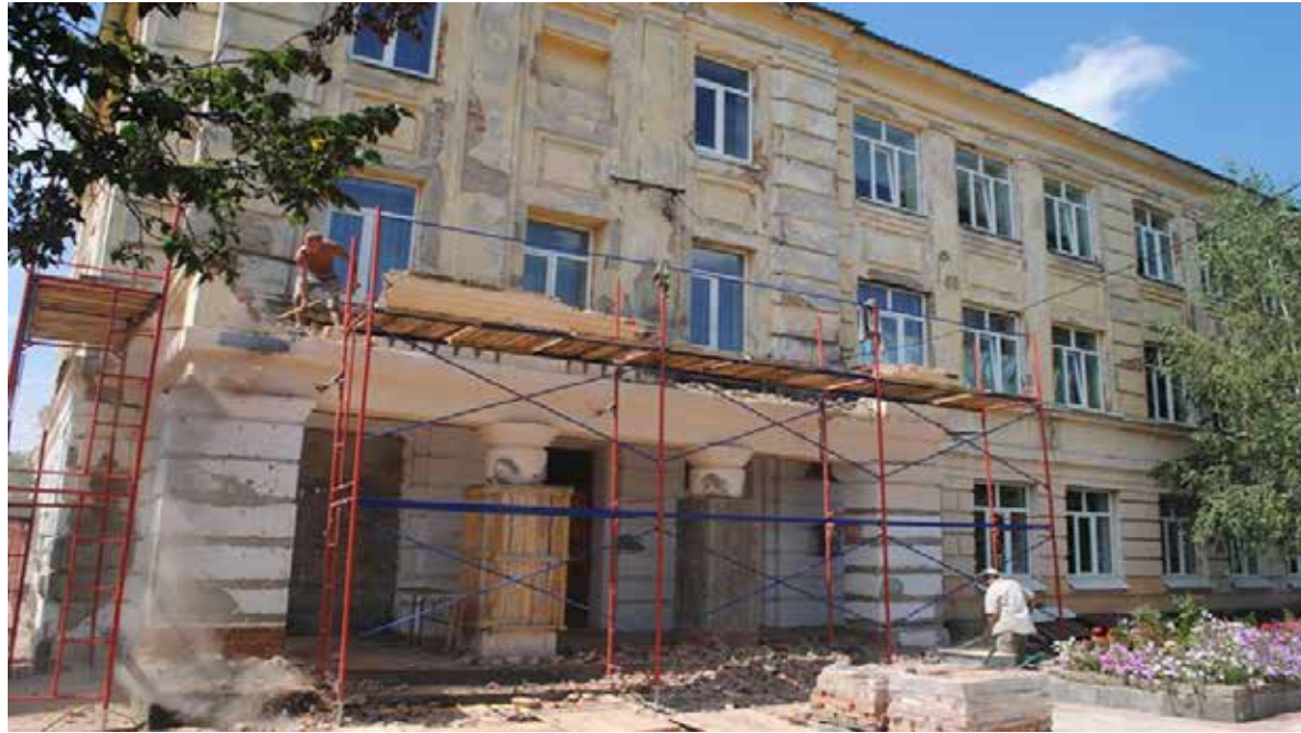
Капітальний ремонт ЗОШ №3, Балтської ОТГ
