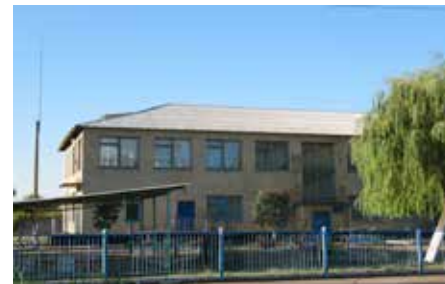
Ремонт даху дитячого садочку в Кочубеївській громаді
