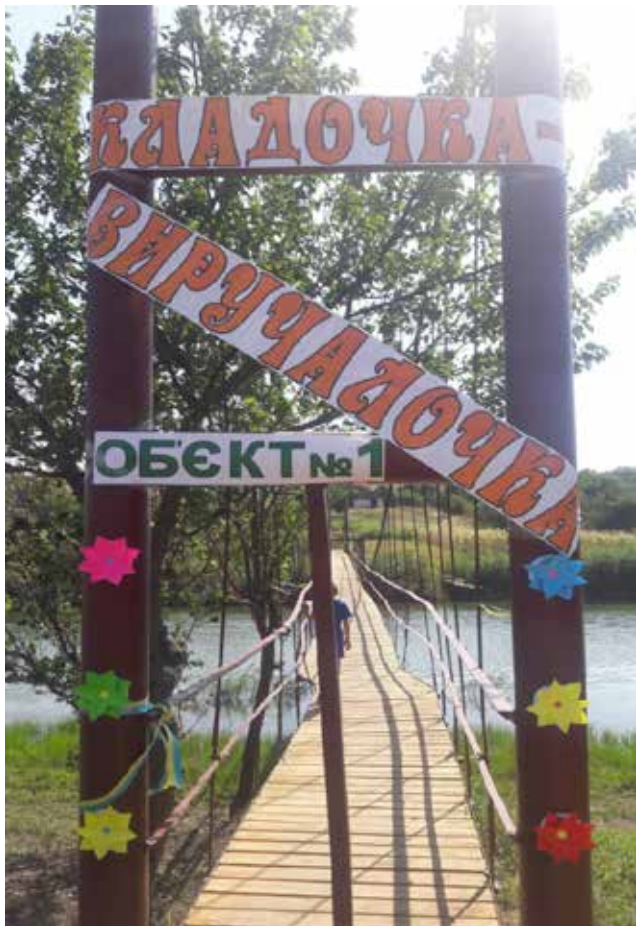
Реконструкція кладочки через річку в Кочубеївській громаді
