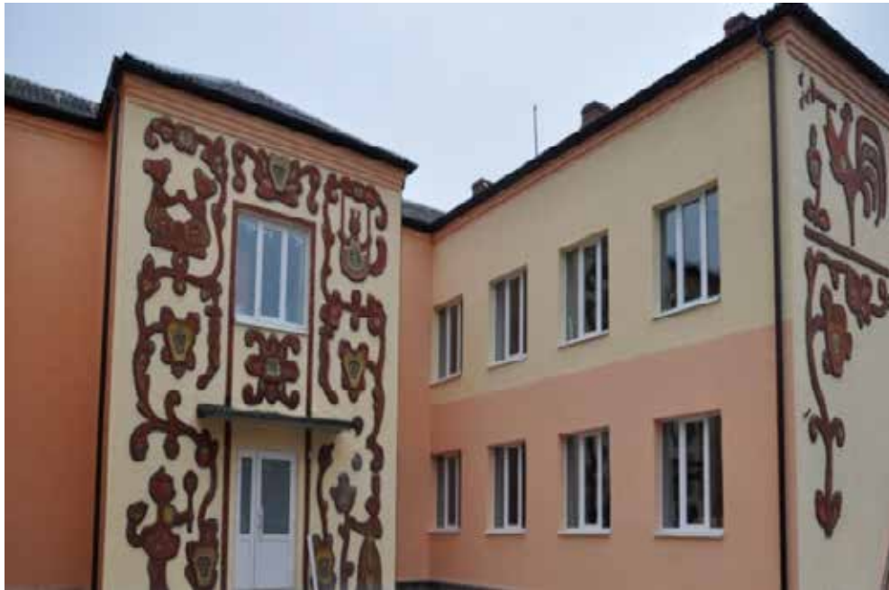
Центр розвитку дитини «Казка» (ремонт будівлі та заміна вікон), Тетерівська ОТГ
