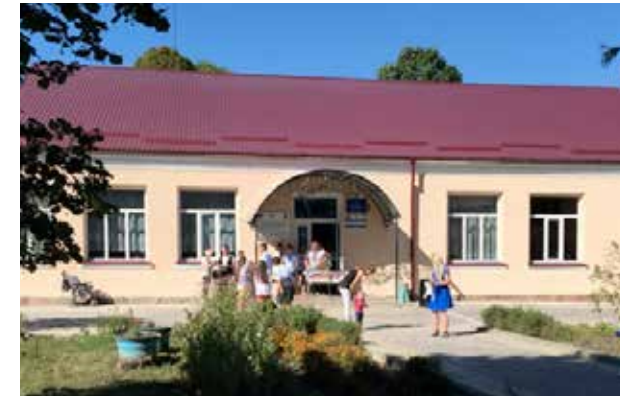
ЗОШ в с.Таурів (перекриття даху, ремонт фасаду, встановлення бруківки), Козлівська ОТГ
