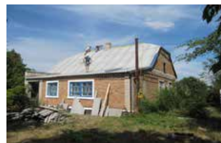
Капітальний ремонт та заміна даху у ФАПі в с.Пригір'я, Кочубеївська громада
