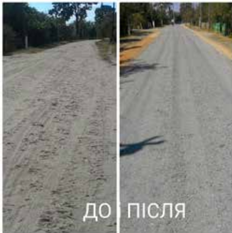
Ремонт вул. Стара в с.Сільце, Велицька громада
