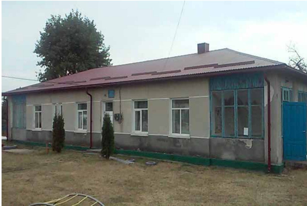
Капітальний ремонт дитячого садка в с. Соколів (заміна покрівлі шатрового даху), Золотопотіцька громада
