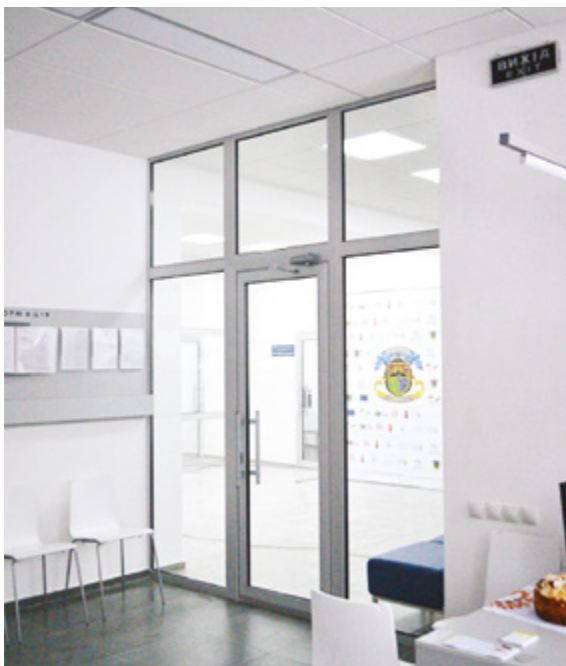
• Металопластикові двері. ЦНАП в Іршанській громаді
