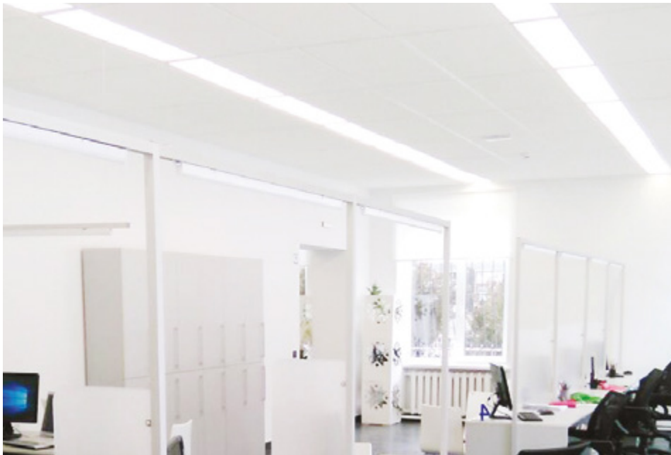
• Виконання підвісної стелі у ЦНАП в Новоушицькій громаді
