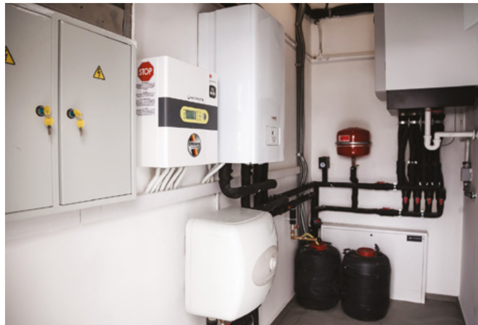
• Система теплового насосу «повітря/вода»
