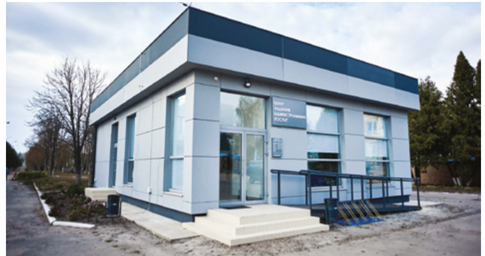
• Будівля ЦНАП у Миколаївській ТГ з SIP-панелей
