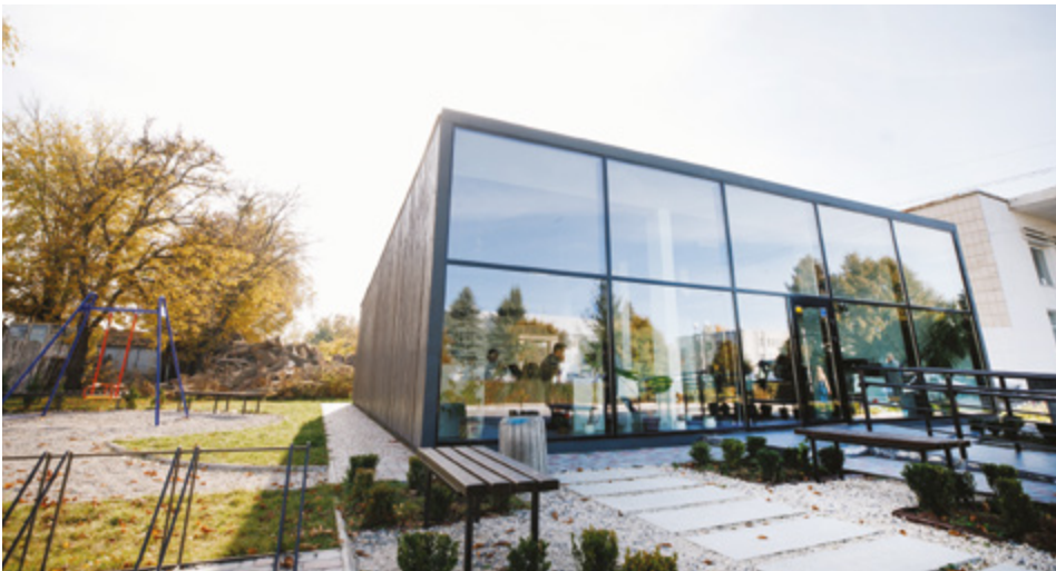
• Будівля ЦНАП у Полонській ТГ з SIP-панелей
