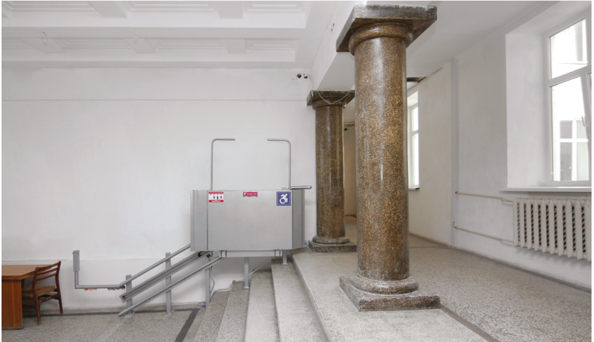
• Пандус-підйомник у приміщенні ЦНАП в Чортівському ЦНАП
