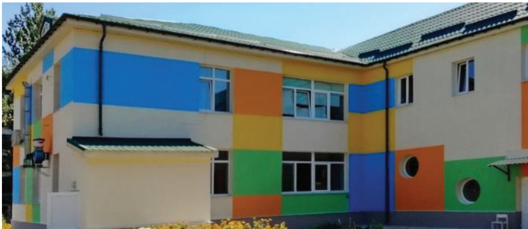
Рисунок 28: Дитячий садочок в Україні до та після утеплення. Джерело: Фотографії зроблено компанією Sweco під час виконання робіт, 2017—2018 рр.
