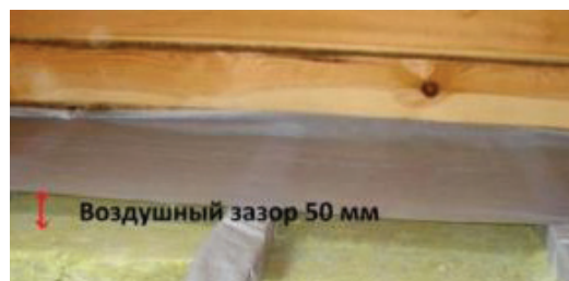
Рисунок. Утеплення пінополіуританом. Утеплення горища мінераловатними плитами.
