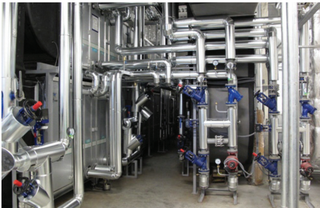
Рисунок. Ефективна теплоізоляція трубопроводів.
