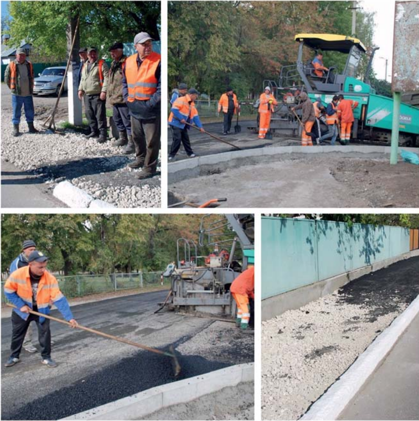
Рис. 11. Ремонт доріг Волочиська ОТГ
