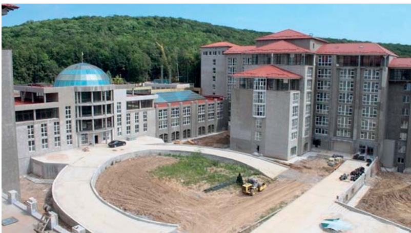
Рис.7. Будівництво санаторію «Арден Палац»
