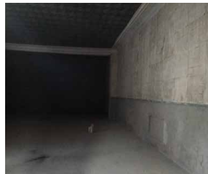
Доманівський коворкінг-центр, до ремонту, січень 2018 р.
