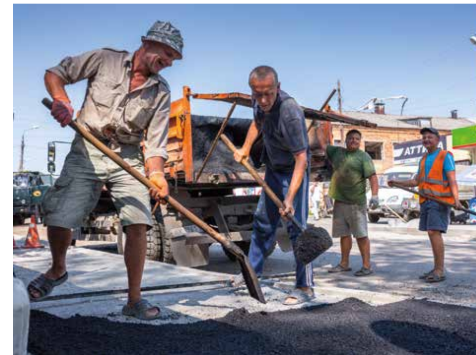
Ремонт дороги у місті Мерефа, серпень 2018 р.
