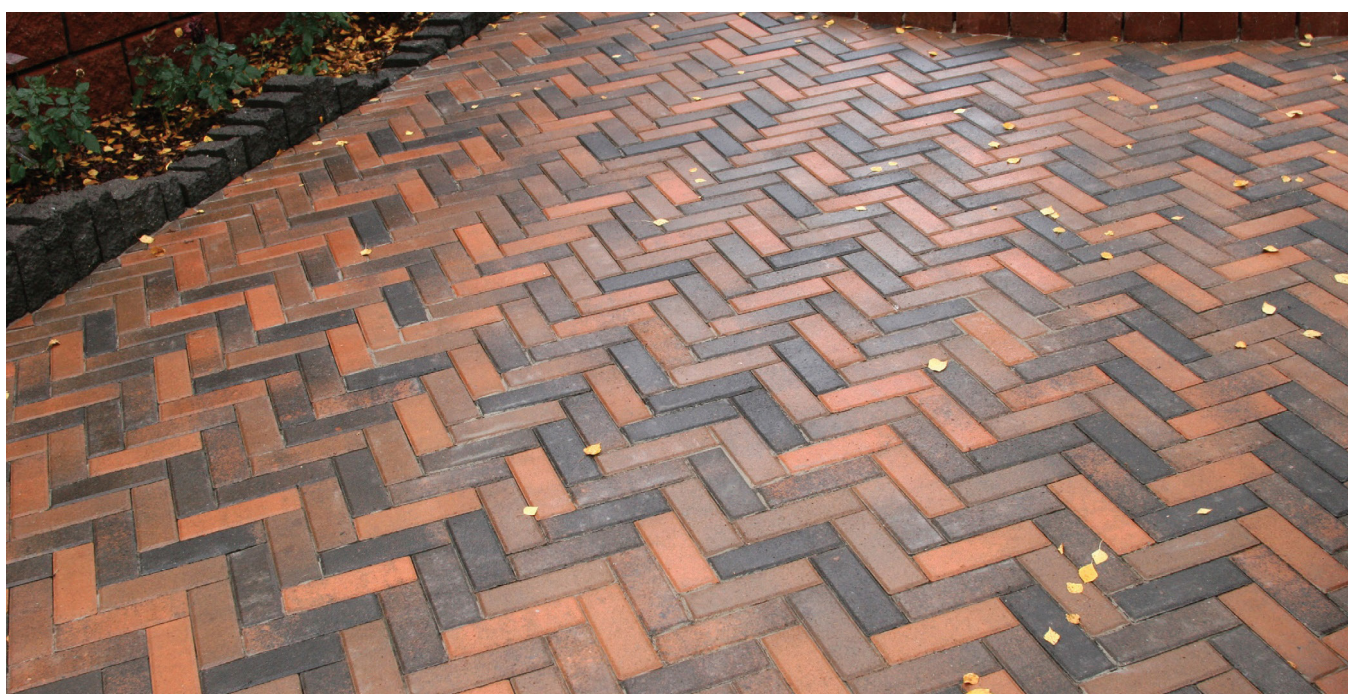
Рис. 8. Укладання ФЕМ способом «паркет»
