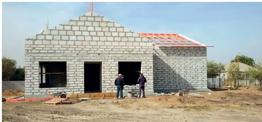
Будівництво амбулаторії. Фото надані авторами кейсу.
